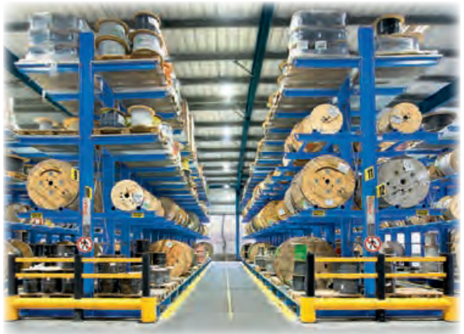
Das neue Kabellager: Mehr Platz für Produkte plus mehr Licht. LEDs sorgen für fast 100 Lux mehr in den Gängen und eine bessere Regalausleuchtung.
